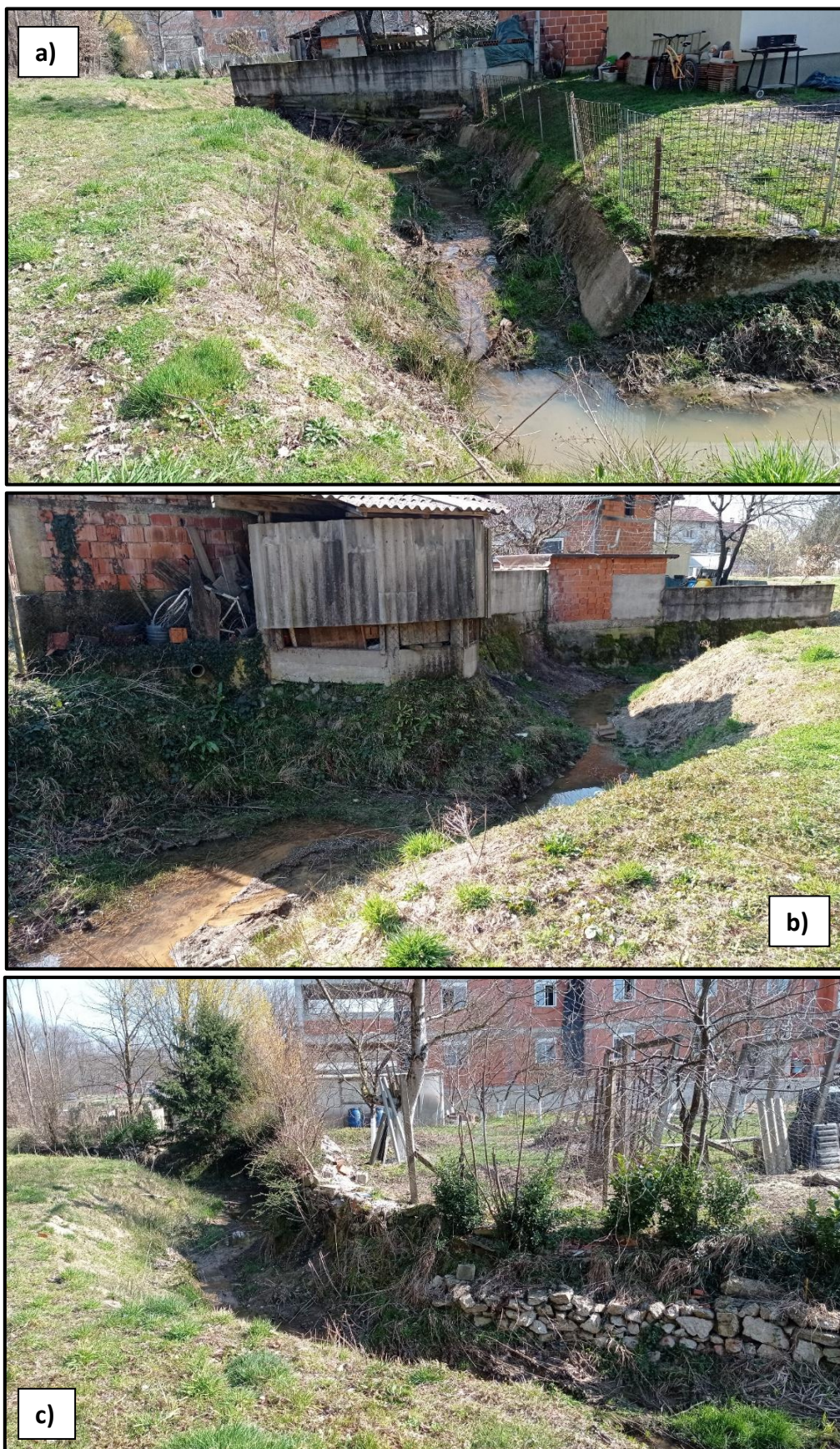
Slika 2.1-2. Dio trase potoka uz postojeće objekte; fotografije poredane od nizvodnijih lokacija prema uzvodnijim: (a), (b) i (c)
