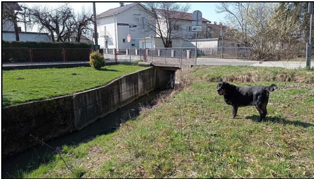
Slika 2.1-1. Početak predmetne trase potoka s pogledom nizvodno na most na Budenačkom putu (stac. km 0+000) i postojeći armirano-betonski zid uz lijevu obalu
